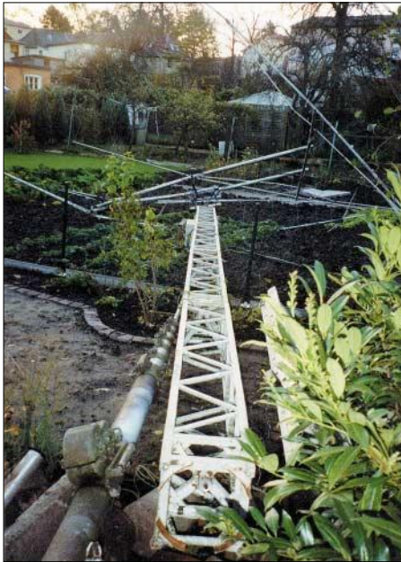
So sieht es aus, wenn einer EME-Station mit 4 x 17-El.-Yagis von M 2 der Gittermast vom Orkan geknickt wird: Jo, DL9MS (JO54), staunte nicht schlecht, als seine 2-m-Antennenanlage in Nachbars Garten lag – natürlich total demoliert!
